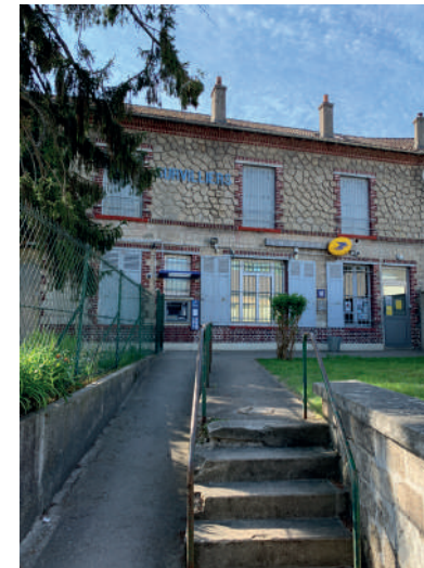
BÂTIMENT DE LA POSTE
