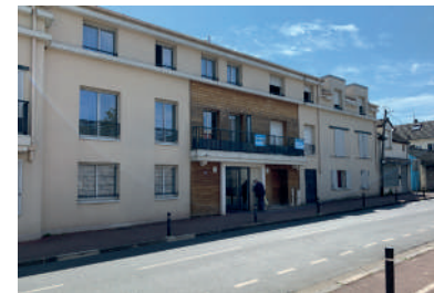
CONSTRUCTION CONTEMPORAINE RUE DE LA LIBERTÉ
