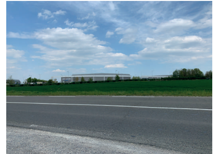
ENTREPÔT DU PARC LOGISTIQUE DE LA PORTE DES CHAMPS
