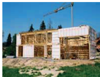
Chantier d'une maison à ossature bois
